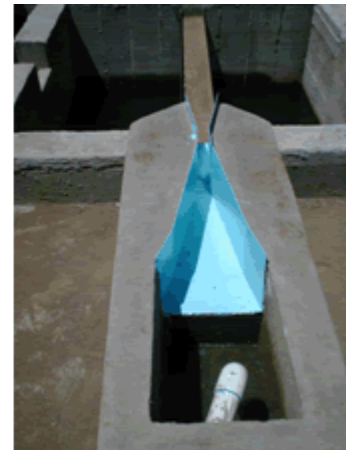
Figura 6. Planta potabilizadora de filtración en múltiples etapas modificada; a la derecha se muestra la llegada del influente a la planta y el canal Parshall, Villa Nicolás Zapata, Totolapan, Morelos.
