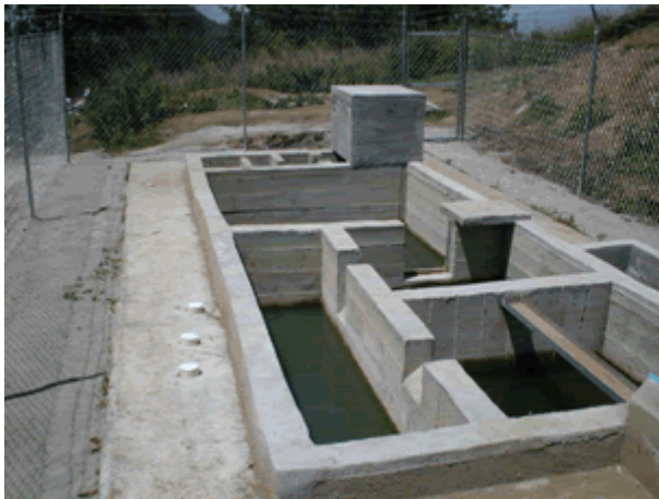
Figura 6. Planta potabilizadora de filtración en múltiples etapas modificada; a la derecha se muestra la llegada del influente a la planta y el canal Parshall, Villa Nicolás Zapata, Totolapan, Morelos.
